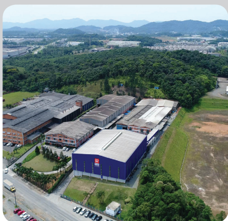
Unidade Joinville - SC
